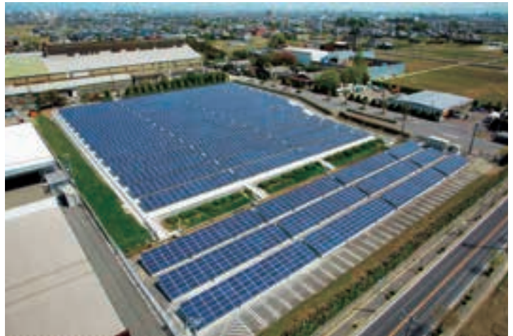
稲沢太陽光発電所（敷地面積 約12,600㎡） Inazawa Solar Power Station (site area: approximately 12,600 m 2 )
