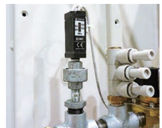
エア源圧カススイッチ Pressure switch for air source
