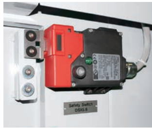
ドアインターロック(電磁ロック式) Door interlock(Magnetic lock type)
