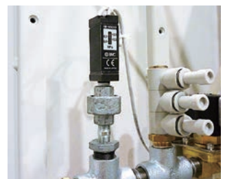
エア源圧カスイッチ Pressure switch for air source
