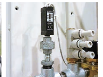
エア源圧カススイッチ Pressure switch for air source
